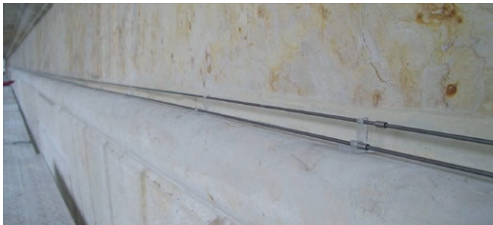
Fig.3: Esempio di installazione di un impianto elettrificato per l'allontanamento dei volatili.
