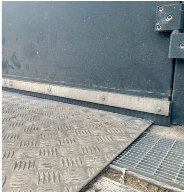
Fig. 1: esempio di installazione di guaina sottoporta
