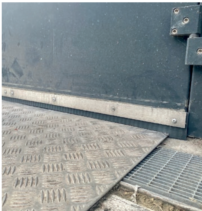
Fig. 1: esempio di installazione di guaina sottoporta
